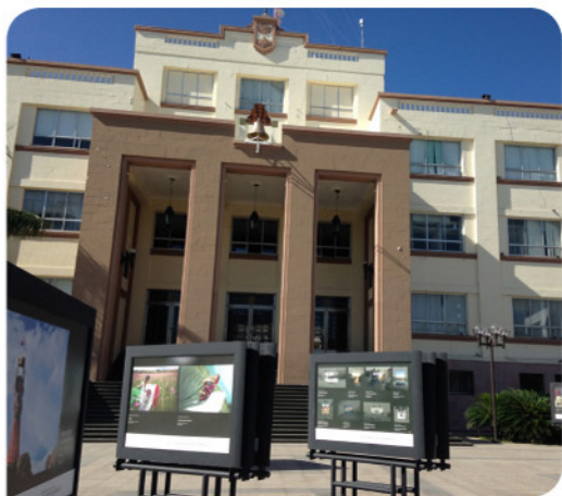
Figura 3.25 Vista exterior del Palacio de Gobierno de Tamaulipas, en Ciudad Victoria, donde trabaja el gobernador de dicha entidad.
